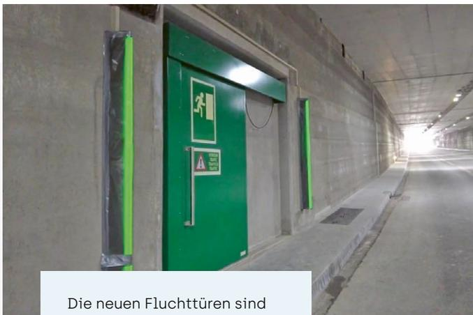
Die neuen Fluchttüren sind als Schiebetüren ausgelegt und ermöglichen eine rasche Evakuierung.
