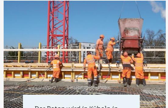
Der Beton wird in Kübeln in die Höhe gebracht.
