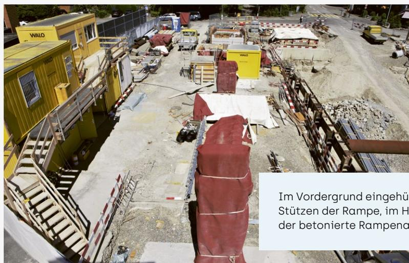
Im Vordergrund eingehüllte Stützen der Rampe, im Hintergrund der betonierte Rampenaufgang.
