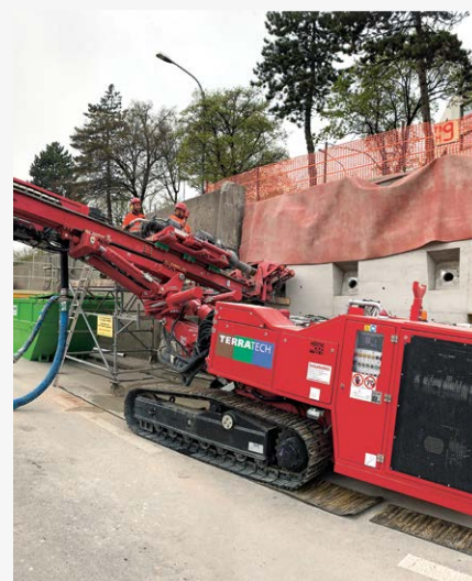
Bohrgerät für die Ankerarbeiten © Locher Ingenieure AG Zürich
