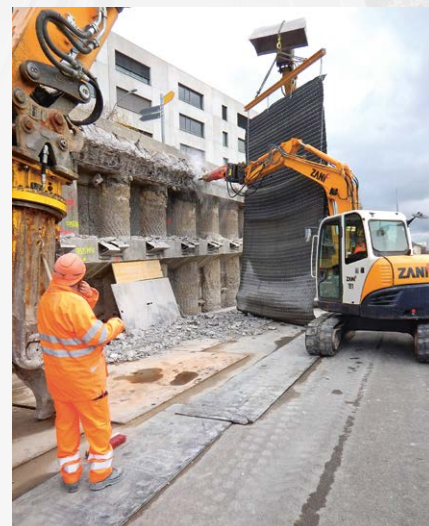
Hydraulikhammer zum Abbruch von Stützmauern und Brüstungen © Locher Ingenieure AG Zürich
