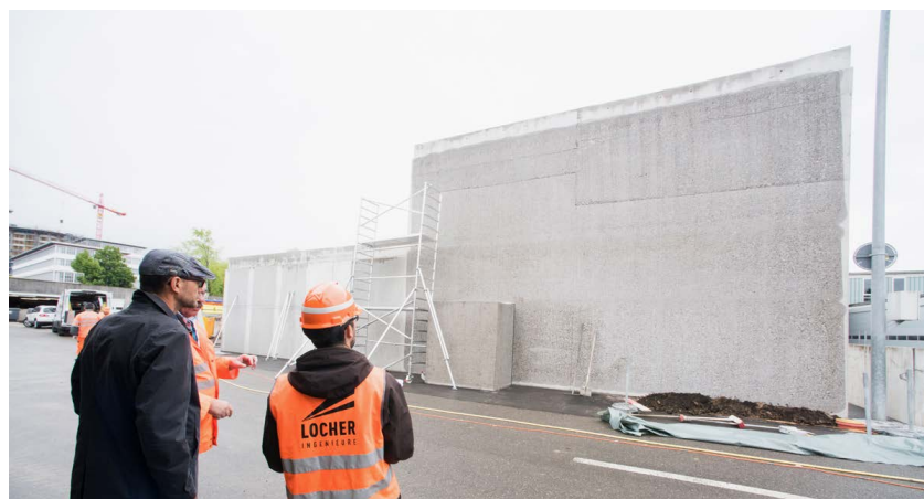
Die Betonmusterfläche im Originalmassstab. (Foto: ASTRA).
