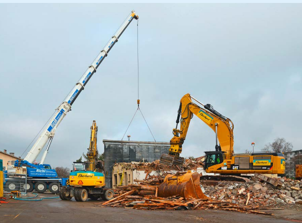
Eine mobile Schutzwand, die von einem Kran gehalten wird, ermöglicht den Rückbau trotz angrenzendem Autobahnverkehr. (Foto: ASTRA)
