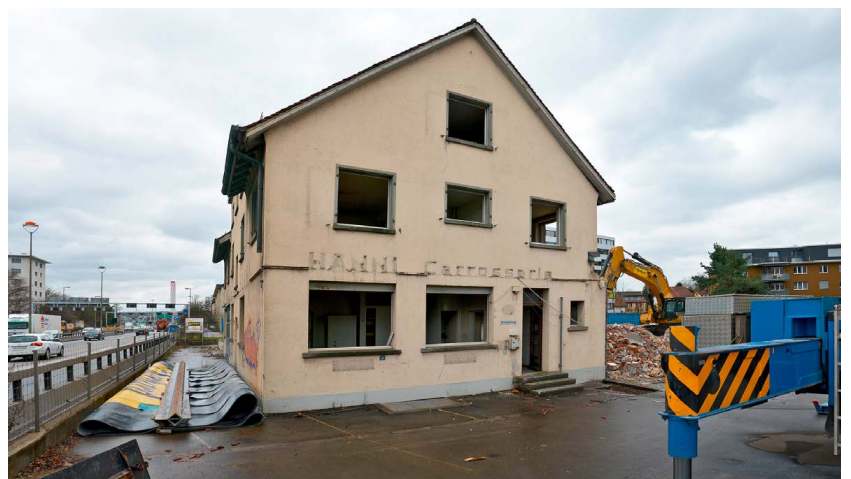
Eines der Gebäude an der Tulpenstrasse vor dem Rückbau. Links davon der zukünftig überdachte Autobahnabschnitt. (Foto: ASTRA)
