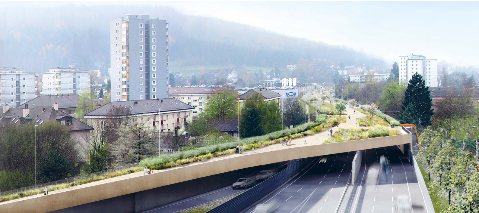
Blick auf das Tunnelportal Aubrugg (Bild ASTRA Infrastrukturfiliale Winterthur)
